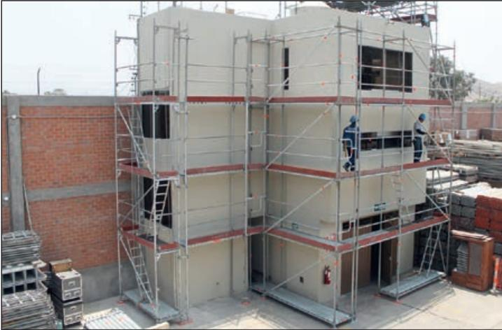
Nuestro sistema Blitz está diseñado para obtener un montaje seguro, reduciendo el tiempo y peso al mínimo con máxima capacidad estructural. Caracterizado por sus elementos ligeros y de fácil montaje, apilables para su correcto transporte.
