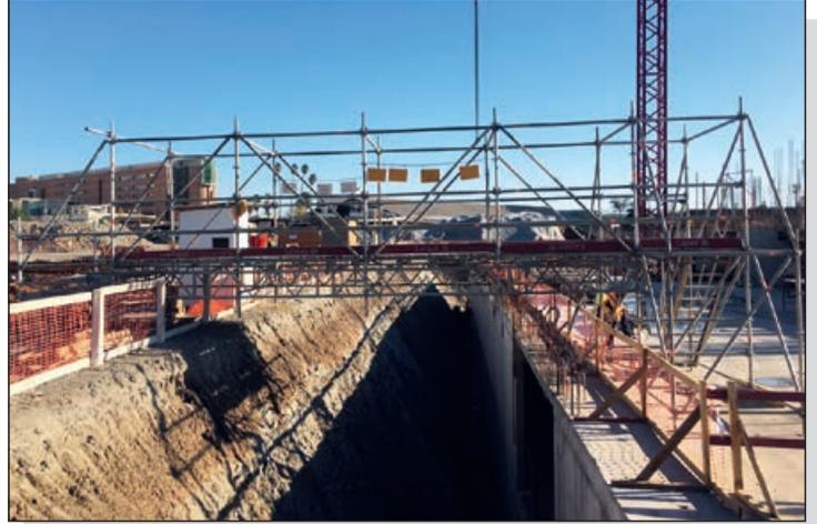
El sistema Allround tiene una capacidad de carga que permite su uso como cimbra, estabilizador de fachada y cualquier aplicación técnica más allá del concepto andamio fachada. Posee una técnica de unión de piezas fácil y segura con ahorro de material y tiempo.
